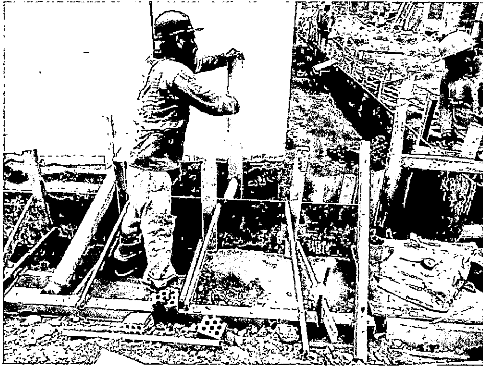
FOTO N°10: Encofrado de vereda.
