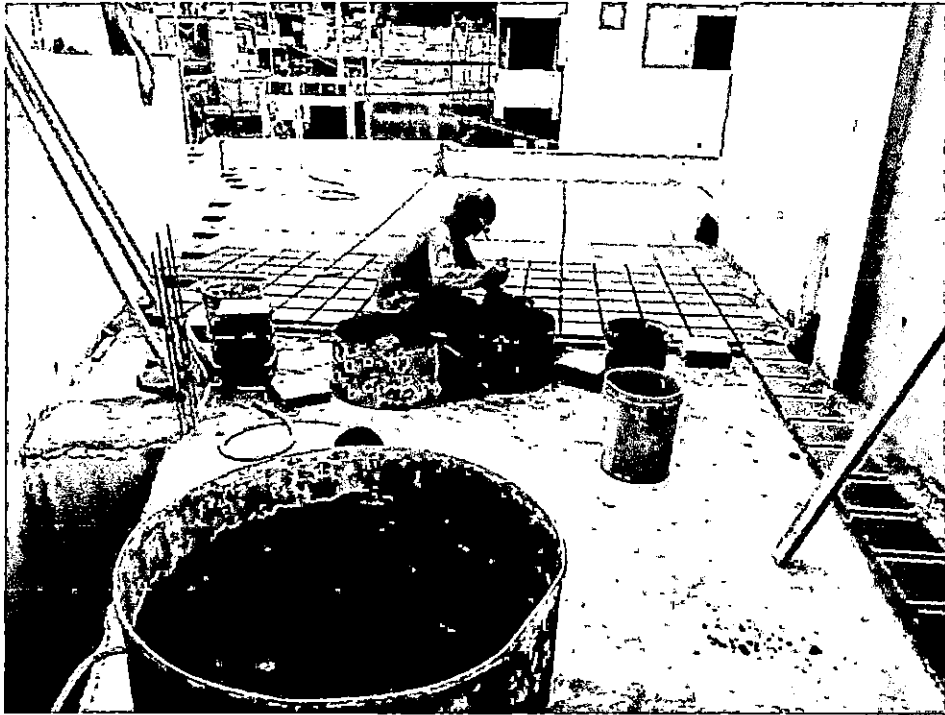
FOTO N° 07: Colocación de ladrillo pastelero, Desinfección.
